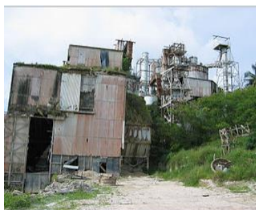
Usine de raffinage du phosphate, tombant en ruines.
